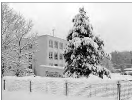
pavilon zvláštních výrob, nyní Technologický pavilon FChT, v první den sněhové kalamity 11. ledna 2010
