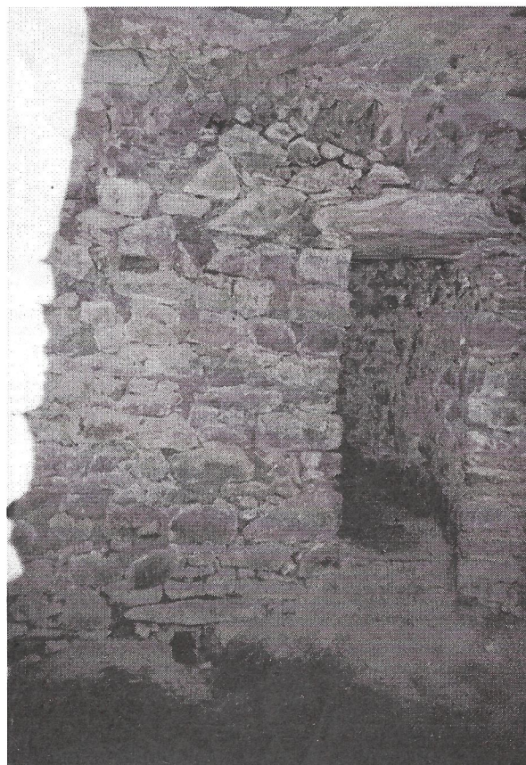
Hrad Falkenstein, vchod do věže (snímek J. Teplý)
