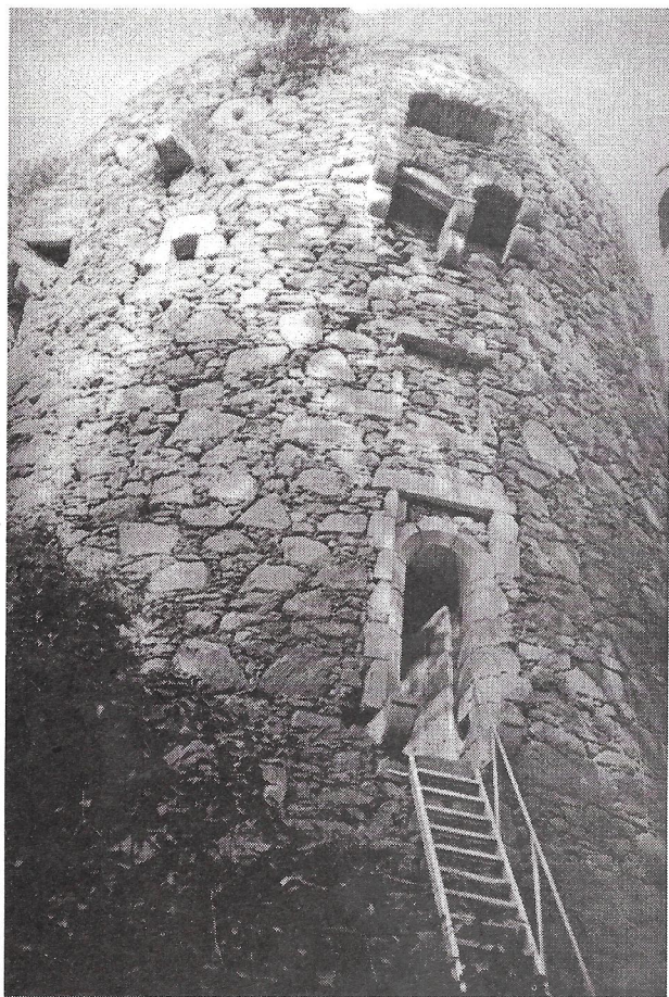
Hrad Falkenstein, vchod do věže (snímek J. Teplý)
