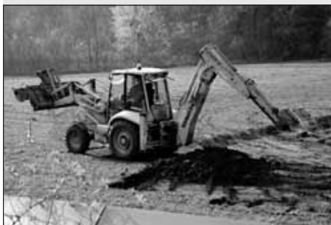
počátkem října 2005 byly zahájeny práce
