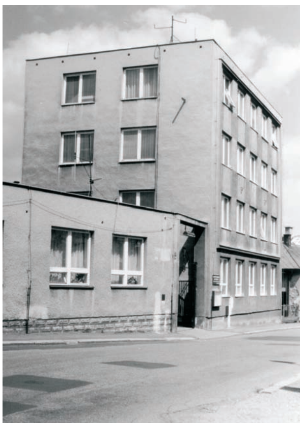
budova dislokovaného pracoviště DFJP Univerzity Pardubice v České Třebové
